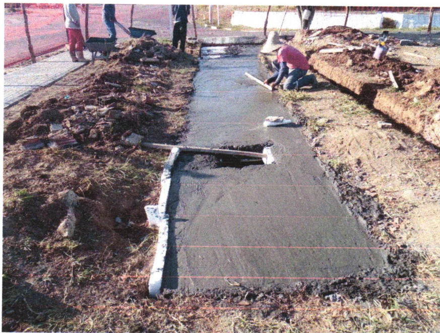
Foto 12 - CONCRETO FCK = 25MPA, TRAÇO 1:2,3:2,7 (EM MASSA SECA DE CIMENTO/ AREIA MÉDIA/ BRITA 1) - PREPARO MECÂNICO COM BETONEIRA 600 L. AF_05/2021
