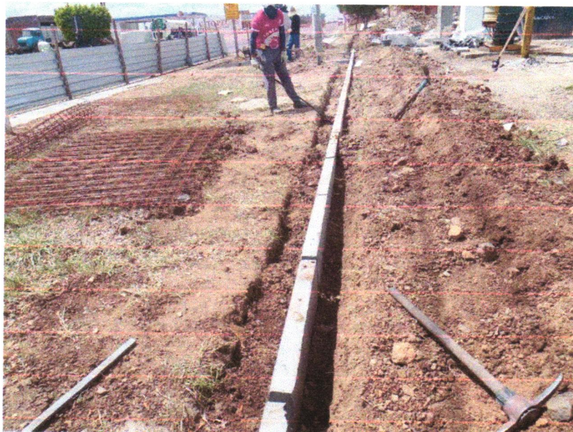
Foto 02 – ASSENTAMENTO DE GUIA (MEIO-FIO) EM TRECHO RETO, CONFECCIONADA EM CONCRETO PRÉ-FABRICADO, DIMENSÕES 100X15X13X20 CM (COMPRIMENTO X BASE INFERIOR X BASE SUPERIOR X ALTURA), PARA URBANIZAÇÃO INTERNA DE EMPREENDIMENTOS. AF_06/2016_P
