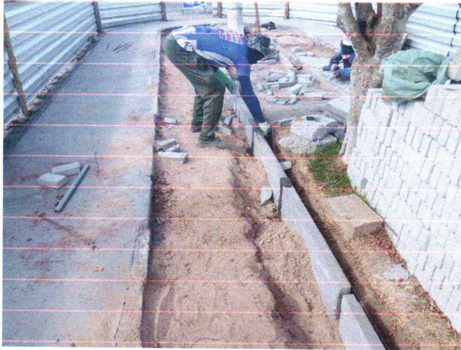
Foto 05 - ASSENTAMENTO DE GUIA (MEIO-FIO) EM TRECHO RETO, CONFECCIONADA EM CONCRETO PRÉ-FABRICADO, DIMENSÕES 80X08X08X25 CM (COMPRIMENTO X BASE INFERIOR X BASE SUPERIOR X ALTURA), PARA URBANIZAÇÃO INTERNA DE EMPREENHIMENTOS. AF_06/2016
