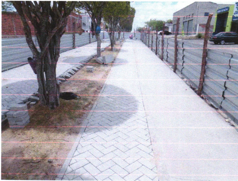
Foto 09- Pavimentação em bloco de concreto vibroprensado, intertravado, cor natural, 10x20cm, e=6cm, 46un/m 2 , NBR9781, Fck(min)=35MPa, sob coxim areia grossa compactada c/ placa vibratória, e(comp.)=6cm, rejuntado c/ areia fina.
